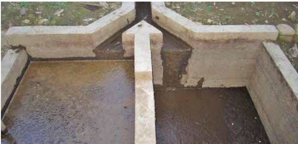
Di dalam penampung *Bio-slurry*, secara lambat laun, akan terbentuk dua lapisan yaitu lapisan padat pada bagian atas (mengambang) dan lapisan cair pada bagian bawah. Jika lapisan padat sudah terkumpul cukup banyak, lapisan tersebut ditangkap berkala menggunakan saringan agar hanya bagian padatnya saja yang terambil.
