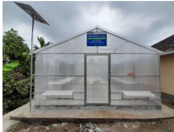
Gambar 14. Rumah kaca yang memanfaatkan energi panas dan listrik dari matahari (Dok. Yayasan Rumah Energi).
