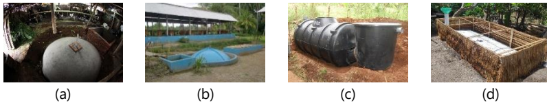
Gambar 21. (a) Model kubah tetap beton, (b) Model kubah tetap serat kaca, (c) Model polietilena, (d) Model kantung plastik.
