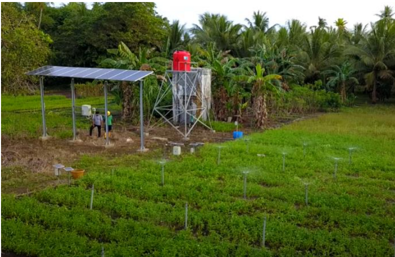
Gambar 9. Sistem PV-Agri (sumber: GIZ Indonesia & ASEAN).
