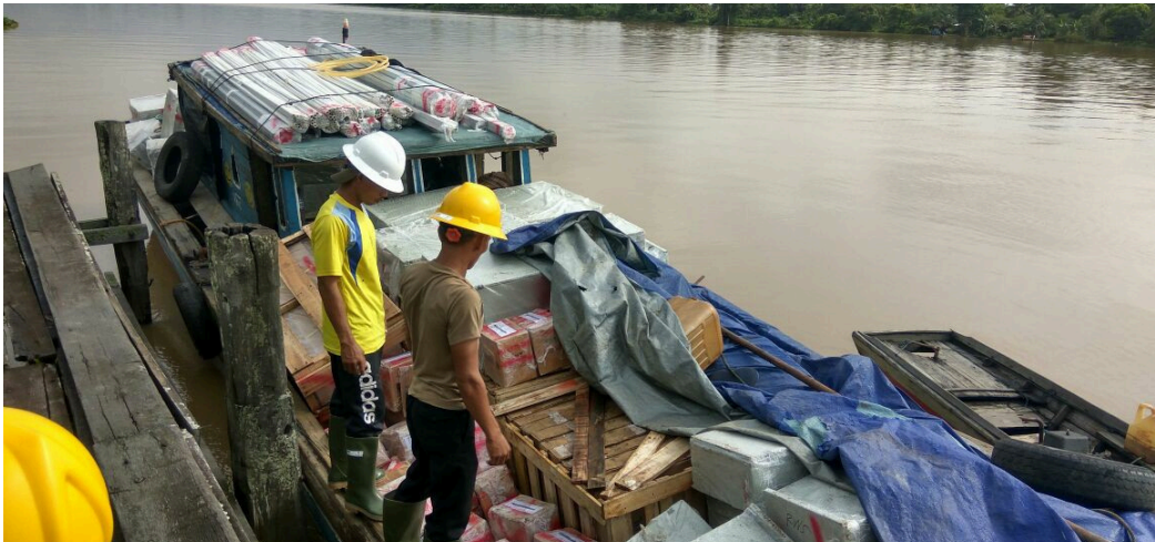
Gambar 3. Proses pengangkutan komponen PLTS menggunakan perahu menuju lokasi yang terpencil di Jambi 3
