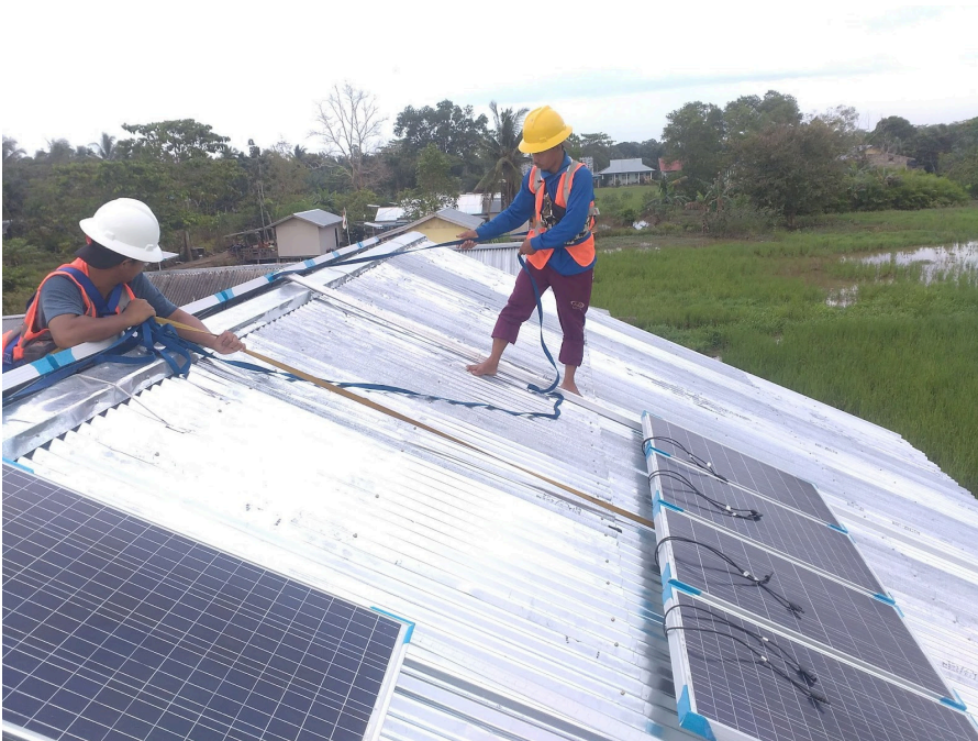
Gambar 8. Teknisi energi terbarukan memasang PLTS atap di lokasi terpencil di Tanjung Jabung Timur, Jambi 8
