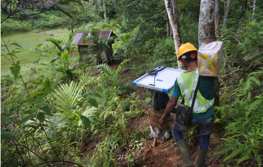
Gambar 7. Pengangkutan manual komponen PLTS di lokasi terpencil di Solok Selatan, Sumatera Barat
