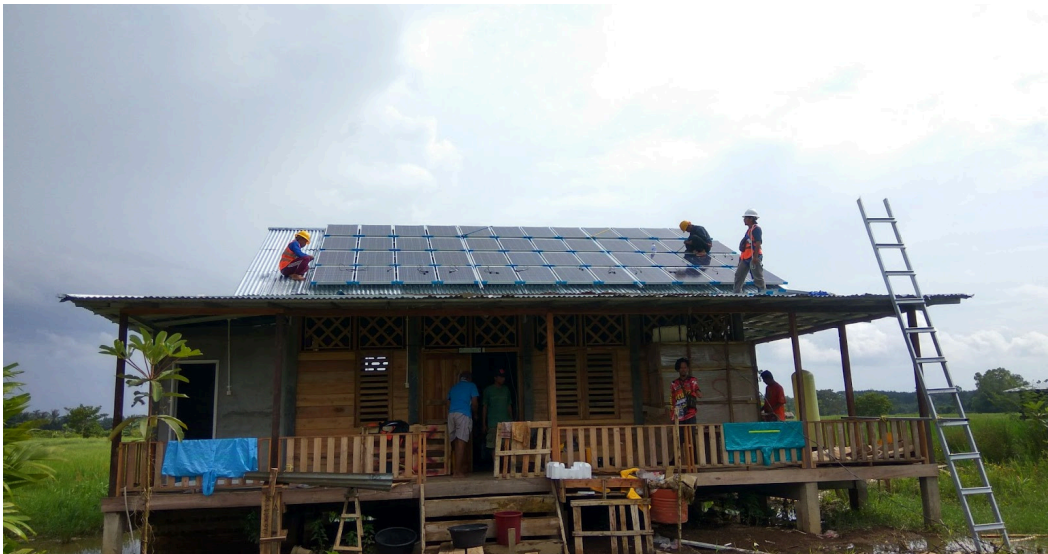
Gambar 2. Proses pembangunan PLTS di Desa Rawasari, Kabupaten Tanjung Jabung Timur, Jambi, pada 2018 2
