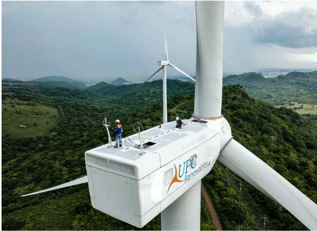
Gambar 12. Pembangkit listrik tenaga angin skala besar di Sidenreng Rappang, Sulawesi Selatan, di mana satu kincir tingginya 80 meter dan berkapasitas 2,5 MW 12
